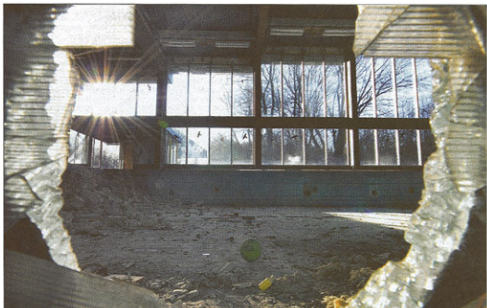
Blick durch zertrümmertes Glas auf den Nichtschwimmerbereich, der bis zur Oberkante verfüllt werden soll. Foto:swita / Udo Mallmann
